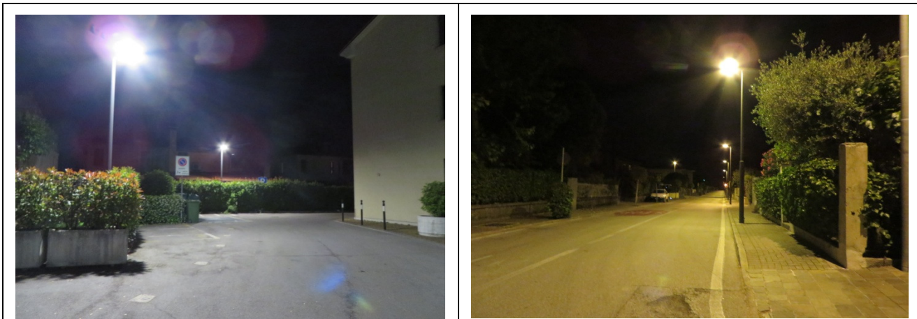
STRADE CON SOVRA ILLUMINAZIONE
