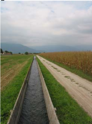
Roggia cementata nella porzione occidentale del territorio
